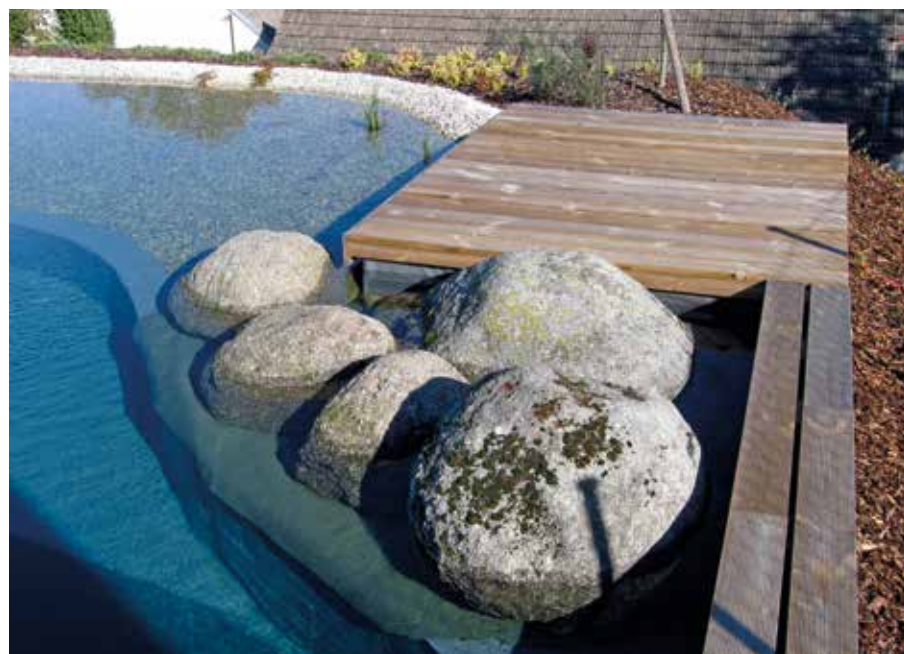
Oddělená betonová šachta s dřevěným zakrytím slouží také jako opalovací molo.
