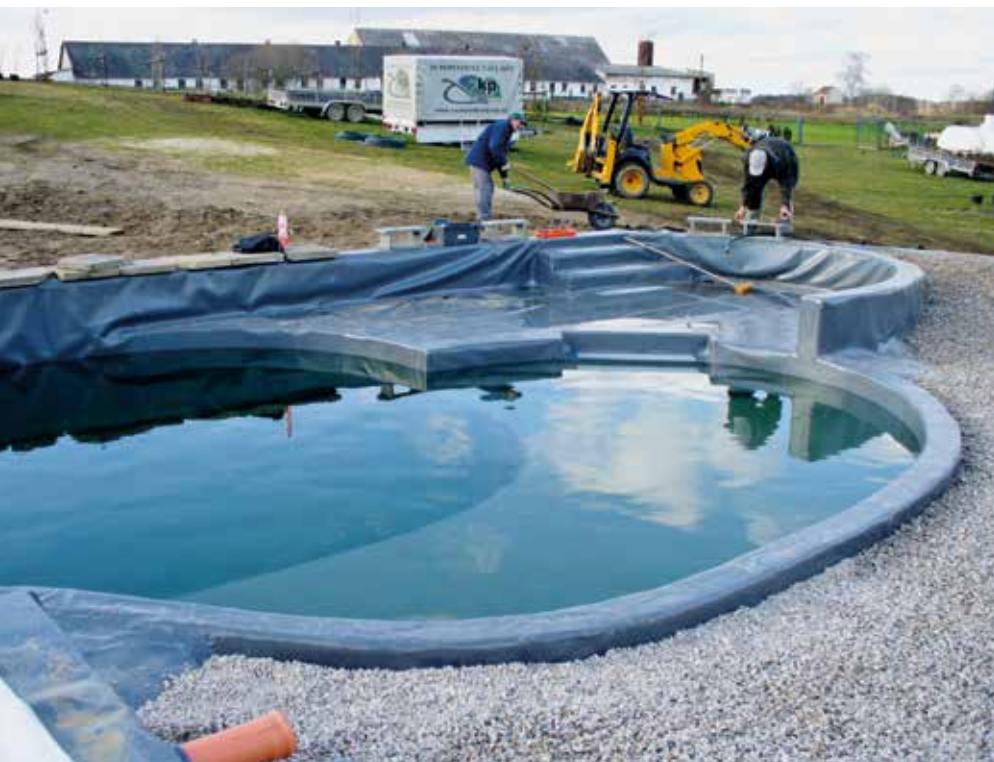
Regenerační zóna má plochu 40 m 2 a je vyplněna kačirkem o zrnitosti 8/16, ve vrstvě 70 cm.
